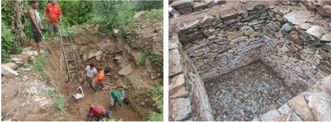
Het graven van het gat voor de waterput en het uiteindelijke resultaat
